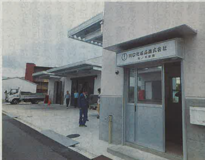
3月に稼働した松ノ木第3倉庫
